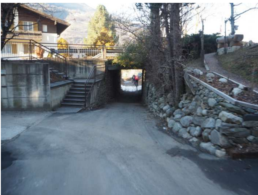
Rad- und Fußgängerunterführung zur L.S. 28
