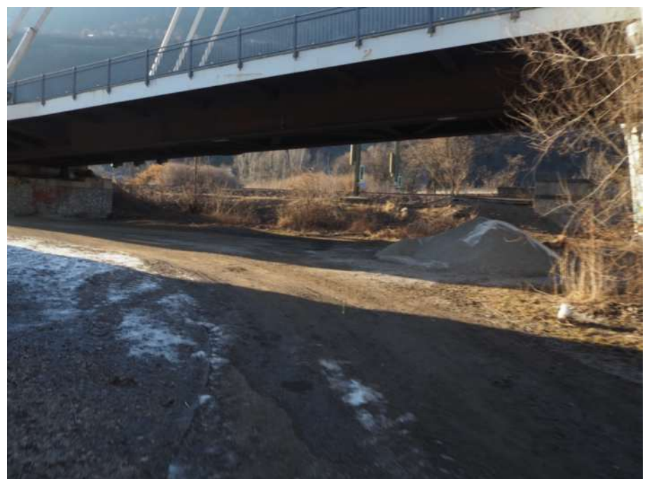
Brücke über den Eisack bei L.S. 28 und der Eisenbahnlinie Brenner - Verona.
