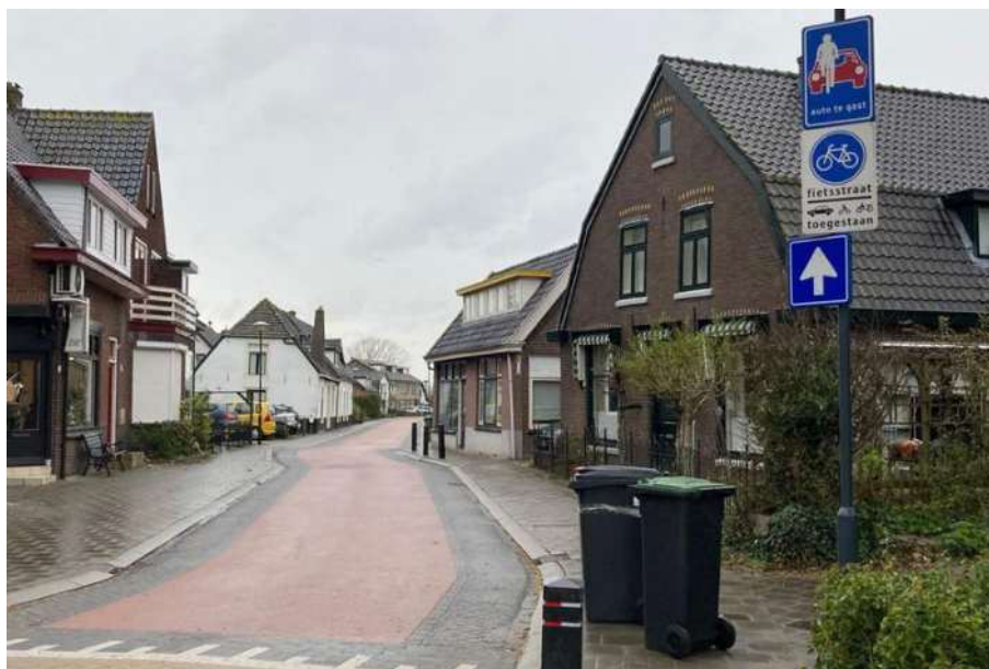
Markierung von Piktogrammen auf E-Bis-Straßen in Reggio Emilia und Fahrradvorrangstraße in den Niederlanden mit speziellen vertikalen Schildern.
